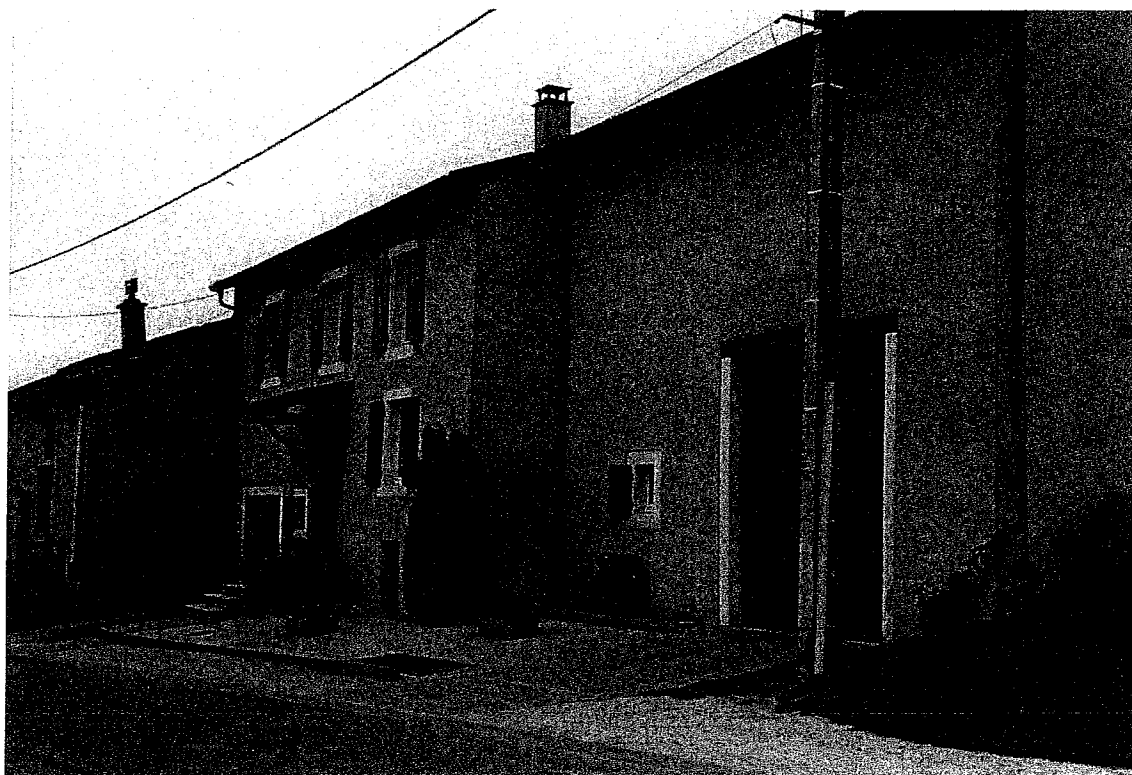
Rénovation de façades , rue du Four à GRAND-FAILLY.
