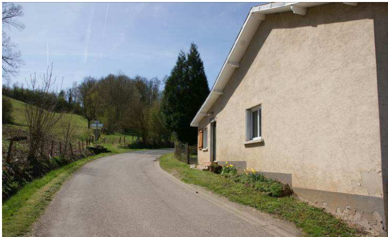
Entrée Flainval, Rue Ernest Bichat, direction Dombasle-sur-Meurthe
