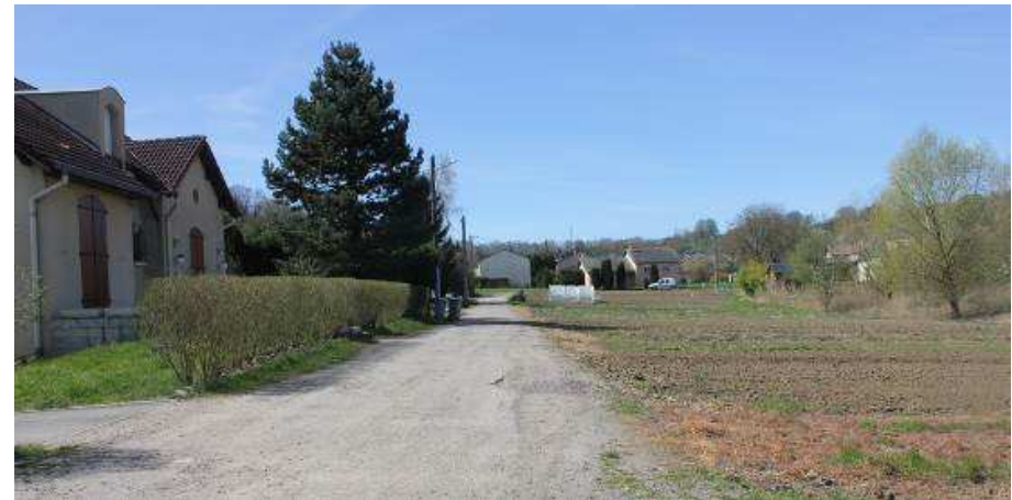
Chemin permettant l'accès à des nouveaux logements sans aménagement pour piéton.
