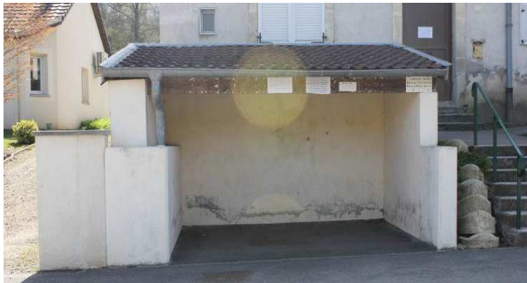
Arrêt de bus, rue Ernest Bichat
