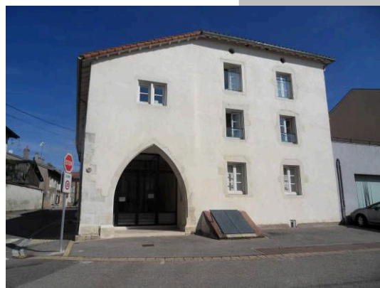
Maison de la Halle, rue de la Halle.
