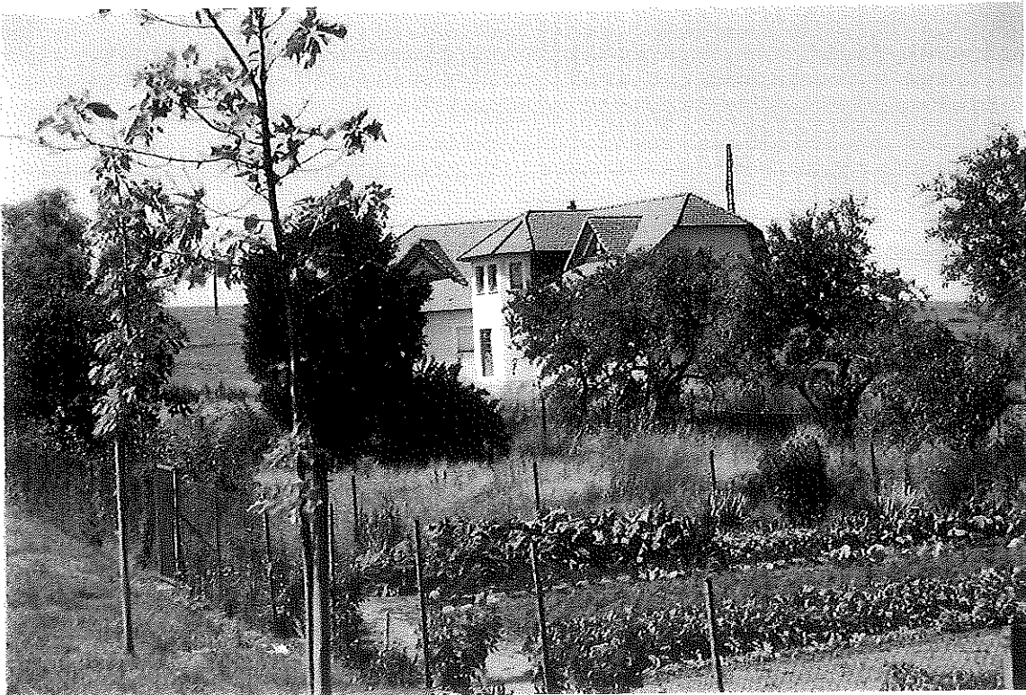
Village de BERTRAMEIX : rue principale, extension pavillonnaire.
