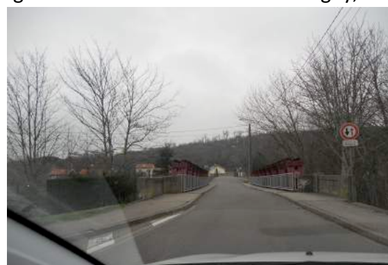
Ouvrages de franchissement du Sânon et du canal
