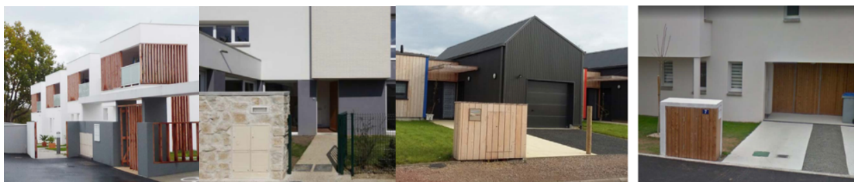
Exemples d'intégration et de coffrets techniques (FICHE PRATIQUE - Coffrets techniques et boîtes aux lettres – CAUE Calvados)
