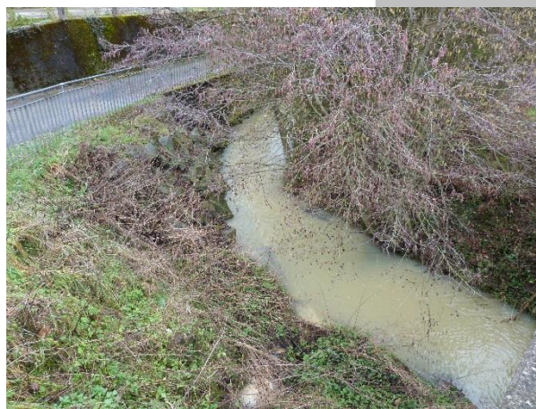
Photo 2 : Vue du ruisseau au niveau du Pont de la RD
