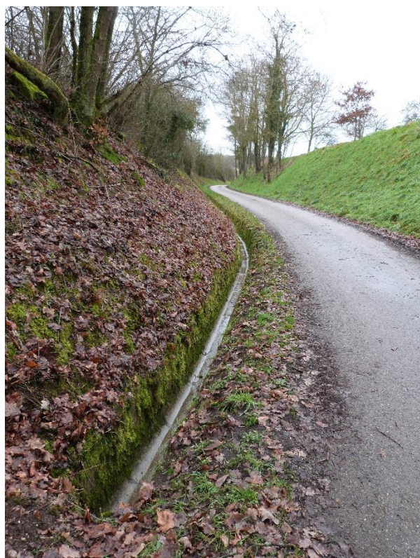
Photo 3 : Vue de la cunette béton du chemin à Le Rouau
