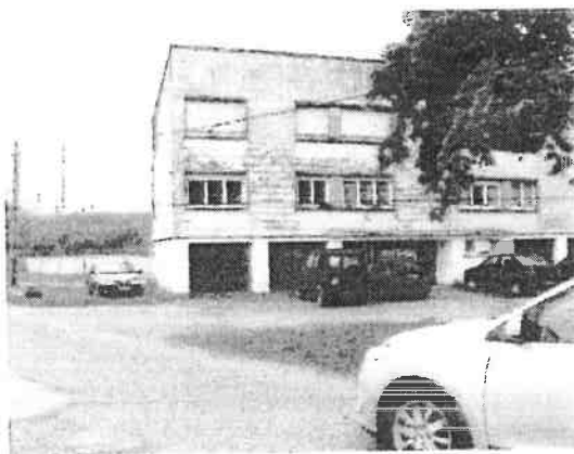
immeuble collectif – chemin de la cartonnerie Photo : CETE de l'est
