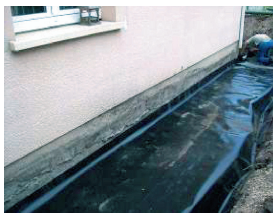
Figure 22 Géomembrane en cours de pose (Source Socabat)
