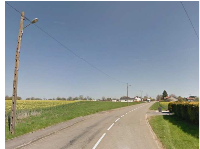
Un trottoir permet de rejoindre le groupement d'habitation de Belle Croix au centre du village
