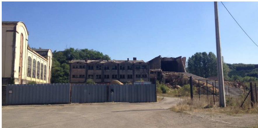
Bâtiments et ruines du site industriel et minier
