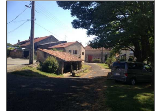
Lavoir à l'étude pour un projet de restauration
