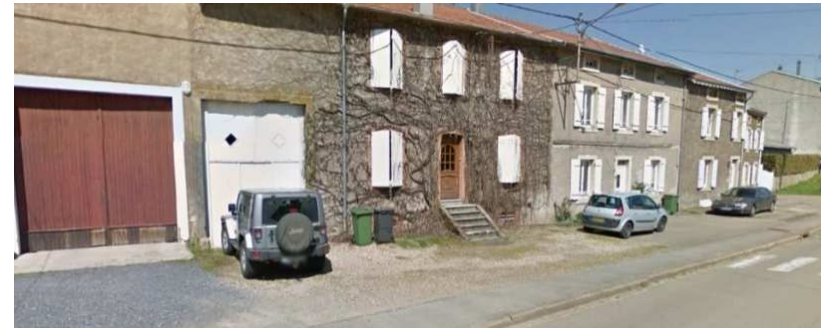
Stationnement de véhicule sur les usoirs. Le centre ancien dispose d'un nombre satisfaisant de places de stationnement qui, n'entravent pas le trottoir piéton.
