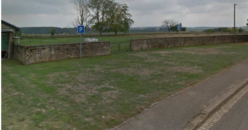
Parking Evergreen localisé devant la Mairie et offrant 8 places de stationnement
