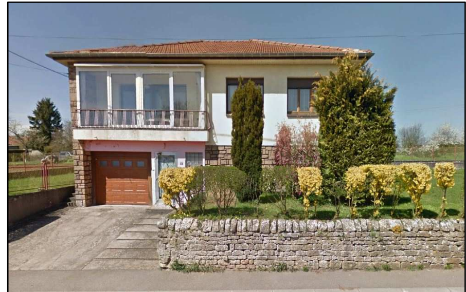
Habitat en extension linéaire le long de la Grande rue et construit sur la période 1970-1980
