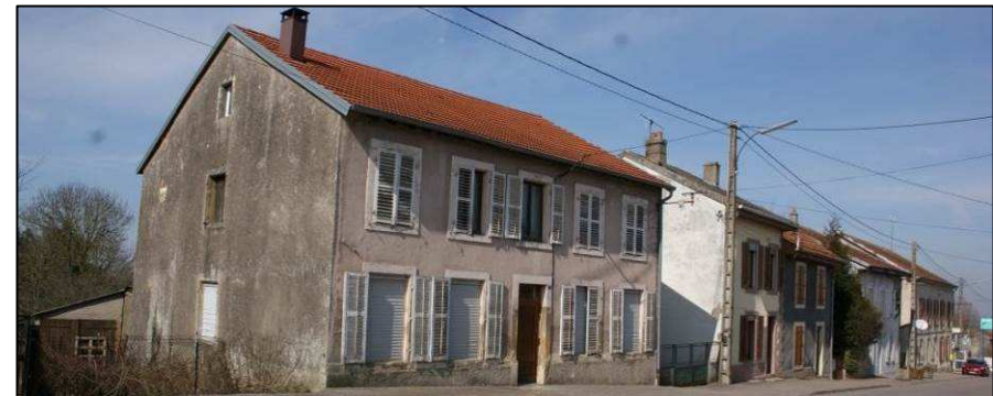
Habitations le long de la Grande Rue
