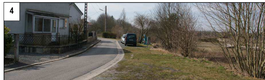
Rue des Rosiers : Voirie simple, double sens. Trottoir étroit d'un côté, stationnement et espace vert de l'autre.
