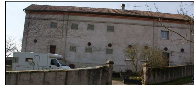
Ancien entrepôt du Magasin Printemps de Paris réhabilité en logements
