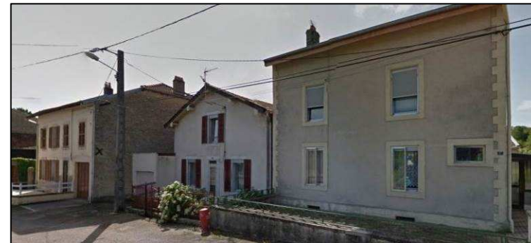
Logements au faitage perpendiculaire ou parallèle rue Carnot
