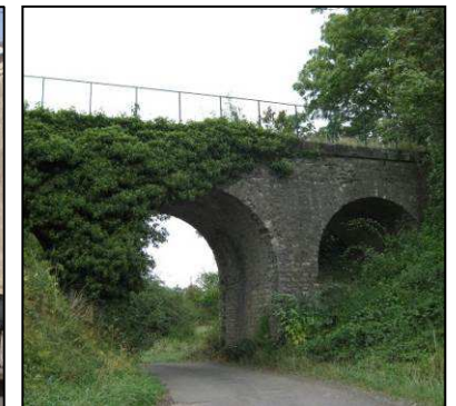
Pont de l'ancienne voie ferrée
