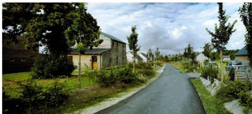
Voie de desserte de logements en sens unique, de largeur limitée (3 m), avec un traitement sobre (pas de bordure) rappelant le cadre rural de la commune
