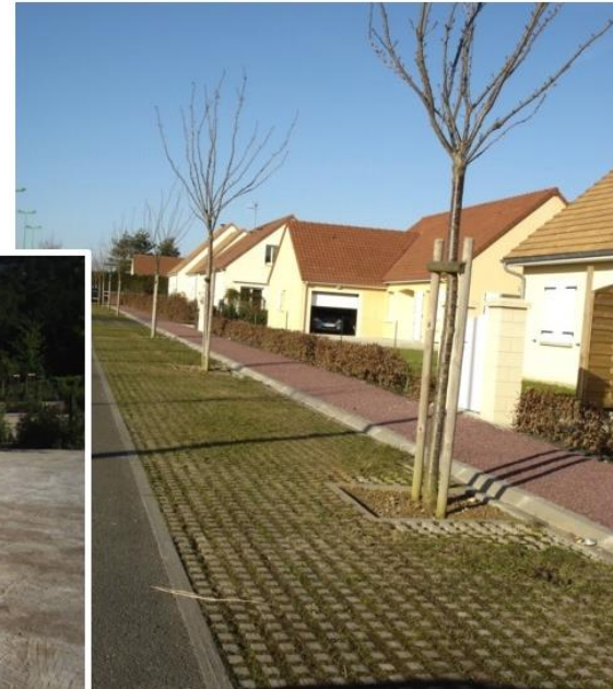
Revêtement à la fois perméable et rigide en bord de voirie sur un lotissement d'Alençon (61).
