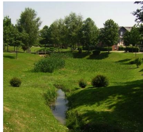
Noue aménagée dans un parc, collectant les eaux de ruissellement des espaces pavillonnaires riverains (76)
