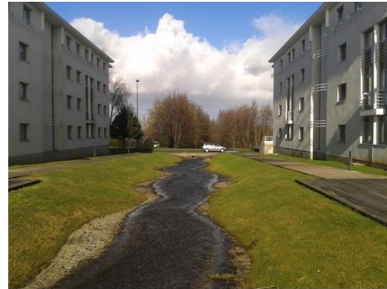
Noue pavée pour limiter son érosion / creusement (14)
