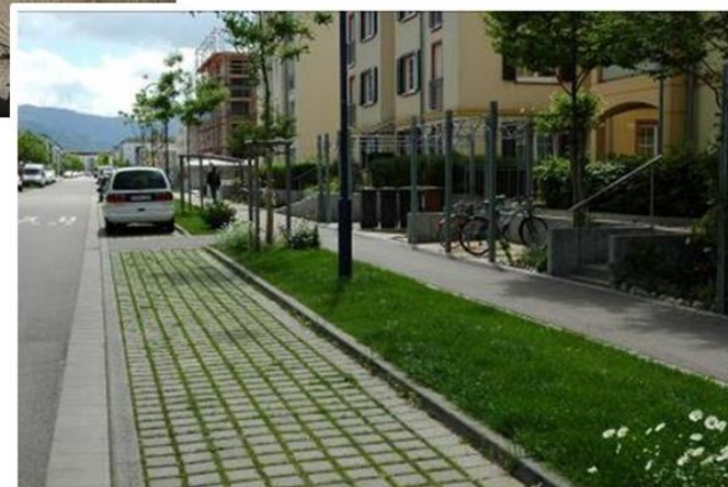
Stationnement en dalle avec joins perméables (Lyon)
