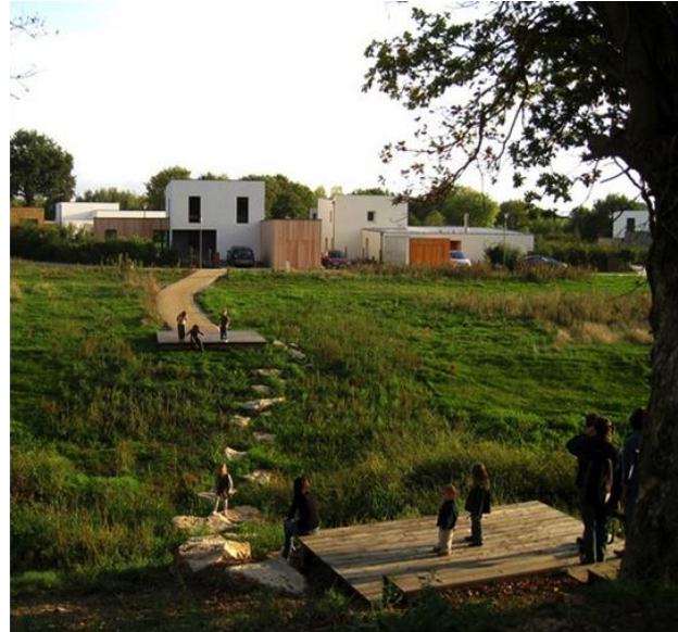
Dépression humide aménagée collectant les eaux pluviales des espaces urbanisés tout proches
