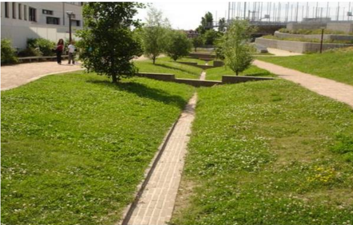
Noue engazonnée + gouttière en dur facilitant le ressuyage / curage
