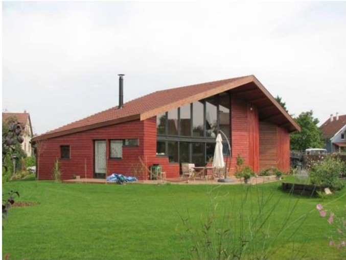
Maison bioclimatique (ouvertures au Sud, ossature bois)
