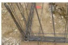
Nœud de chaînage - Continuité mécanique
