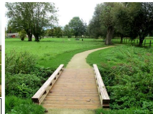
Aménagement d'un pont au dessus d'une zone humide
