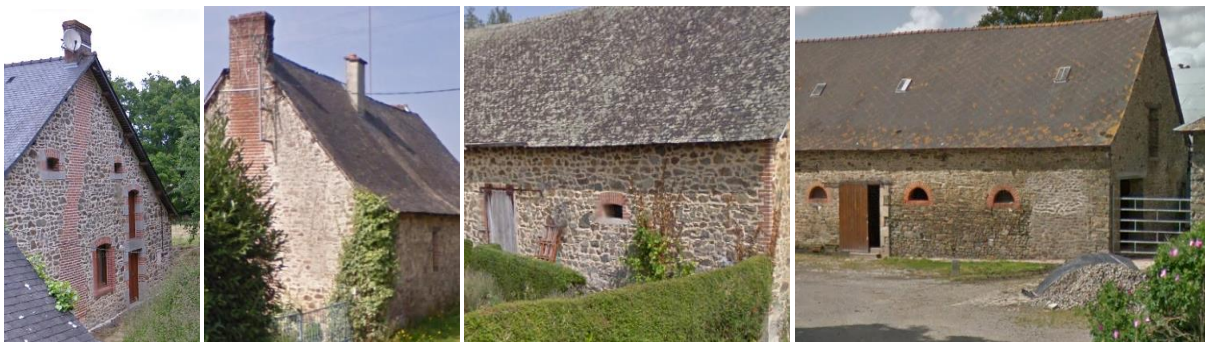
Des toitures à deux pentes en ardoises, des souches de cheminées en briques
