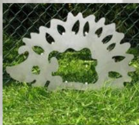
Passage à hérisson installé au pied d'un grillage à mailles resserrées (source : LPO)
