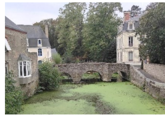
Pont, rue du Vieux Pont
