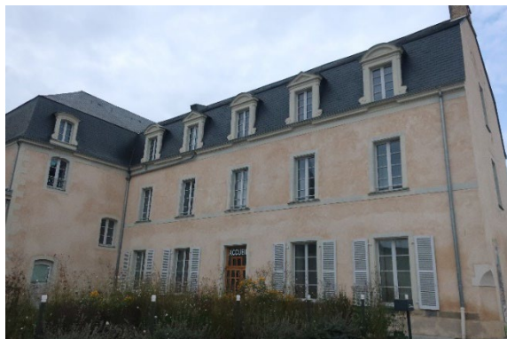
Route Nantes/rue de la Libération
