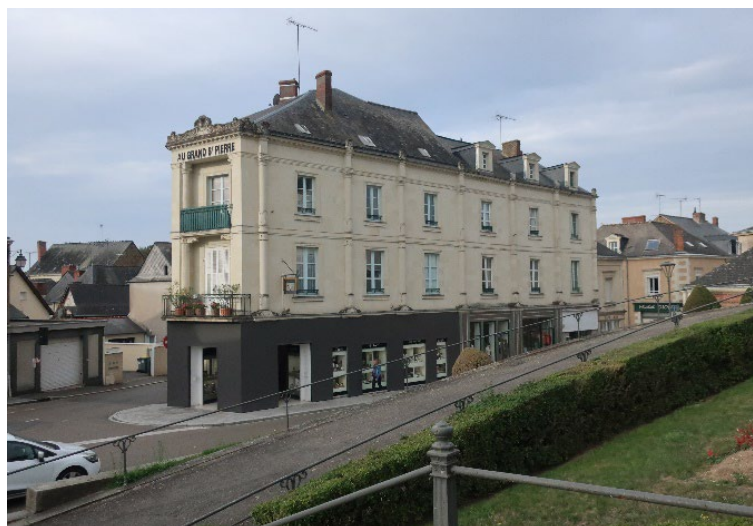
Angle rue Neuve/rue Saint-Pierre
