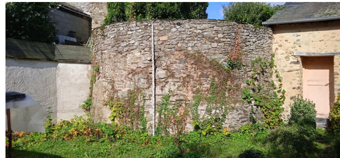
12 – tour dans une propriété rue des Halles
