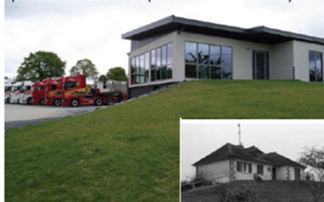
Exemple de création de bureaux dans un ancien pavillon d'habitation (architecte P. Jehannin)
