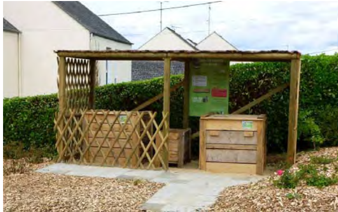
Exemple de composteur collectif installé à Congrier
