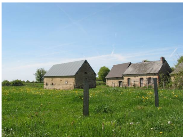
Figure 9 : Patrimoine bâti riche mais à l'abandon
