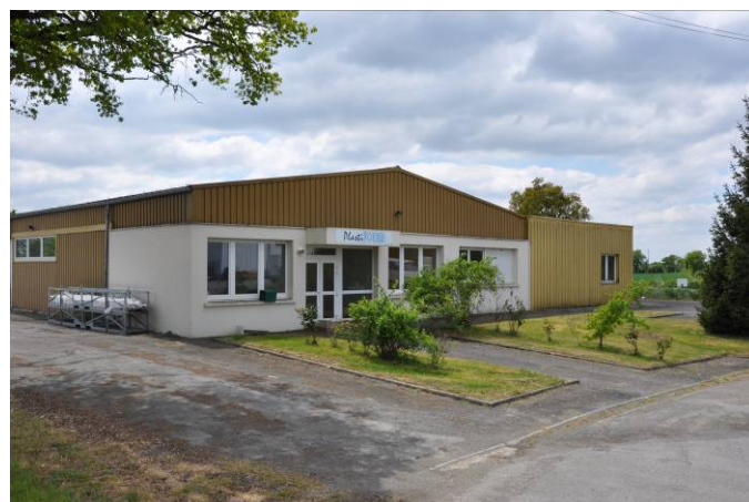
Figure 80 : Zone d'activité située en retrait de l'entrée de bourg
