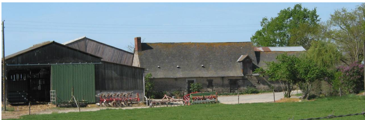
Figure 8 : Corps de ferme
