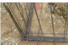
Nœud de chaînage - Continuité mécanique
