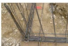
Noeud de chaînage - Continuité mécanique
