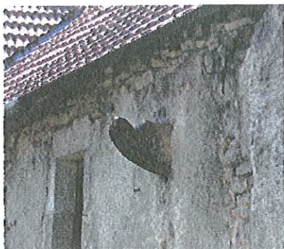
Support de gouttières en pierre
