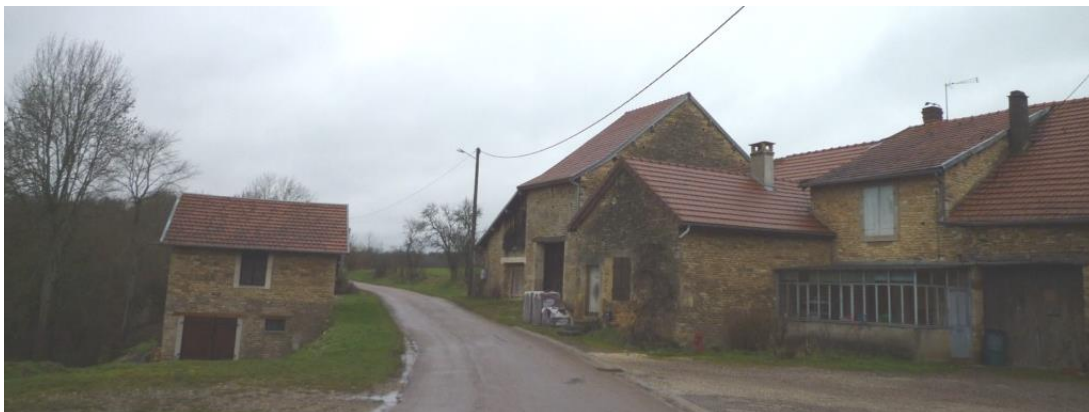
Entrée Ouest (dans le sens de la sortie)
