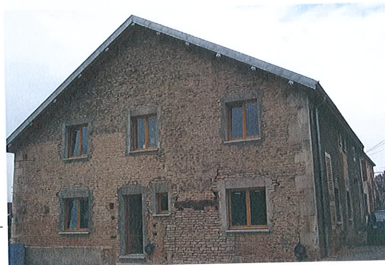
Habitation en cours de rénovation – rue de Bretagne
