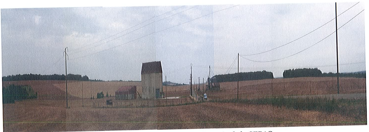
Les silos de stockage et vente de grain de la SEPAC implantés en bordure de la D 1 vers AGEVILLE et RIMAUCOURT
