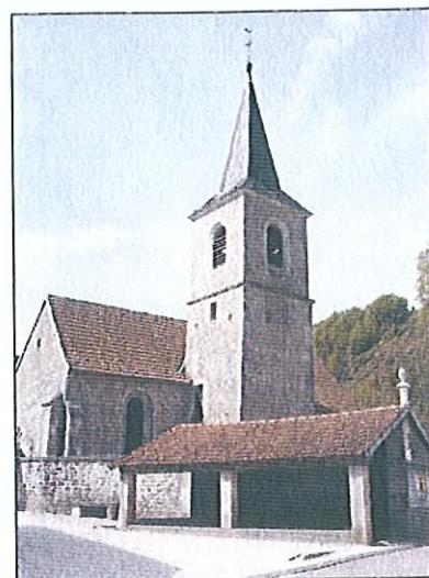
L'église St Thomas de Cantorbery et le lavoir accolé
