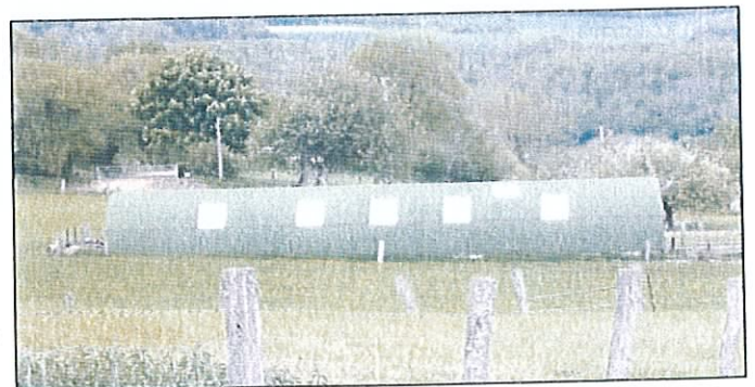
Un bâtiment d'élevage situé route de la Sablière
