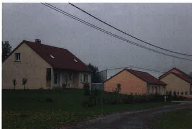
Rue des Ochières à LONGEAU
