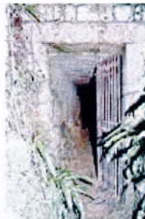
Entrée de l'aqueduc
