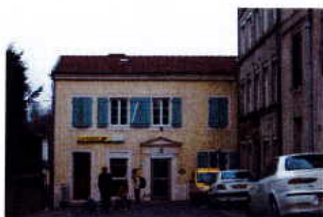
Poste Rue de Montcault
