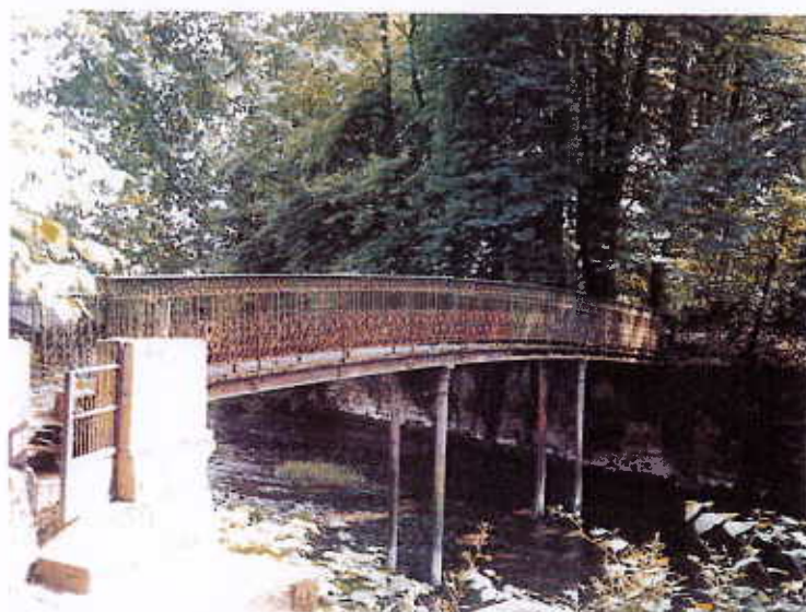
Passerelle au dessus de la Blaise à Eclaron
