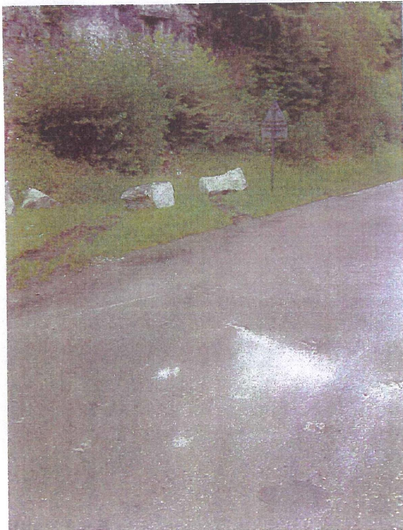
Illustration 3 : Vue particulière sur les impacts sur la route et l'emplacement initial des blocs
