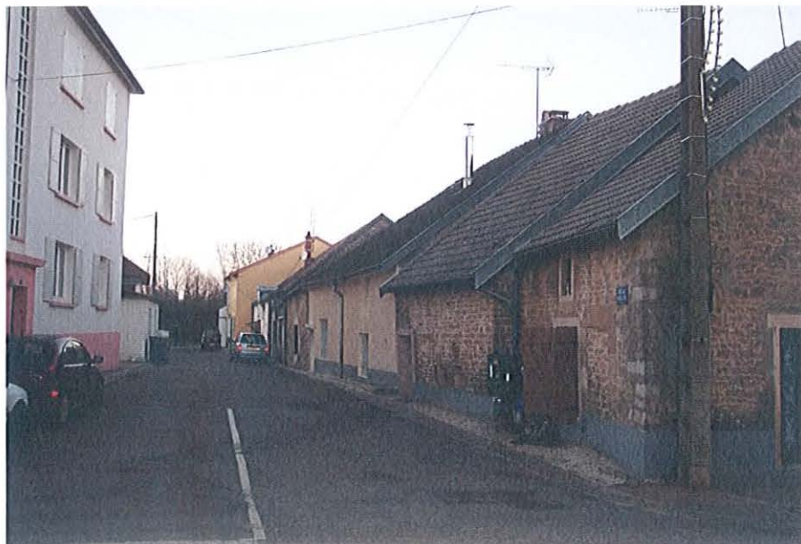
Habitat ancien et récent Rue des Patouillets
