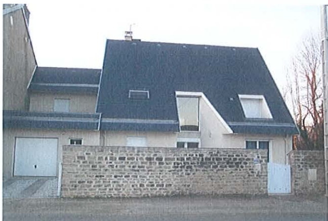
Construction récente Rue de la Gare
