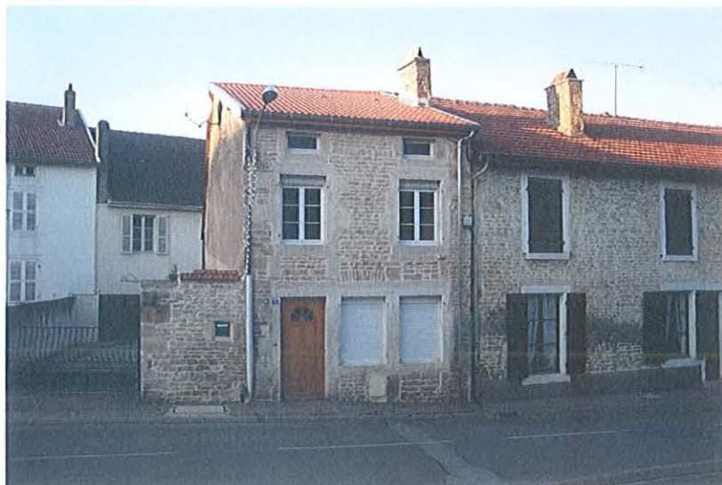
Bâti ancien Rue de la Fontaine à Bologne
