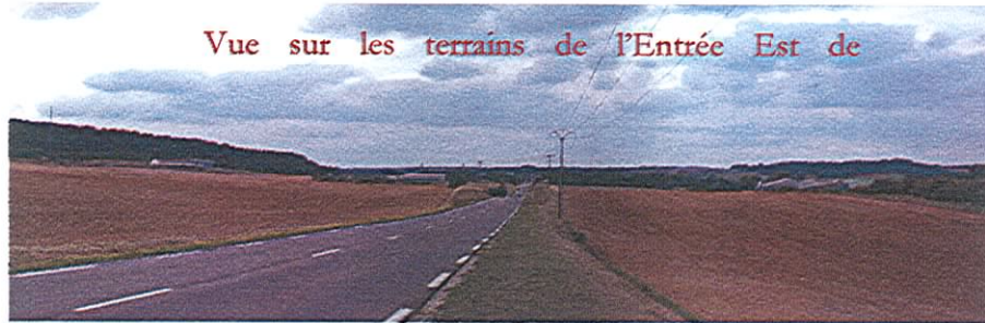
Vue sur la zone d'activité et les terres agricoles
