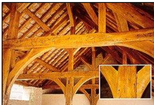
Rénovation de la charpente
