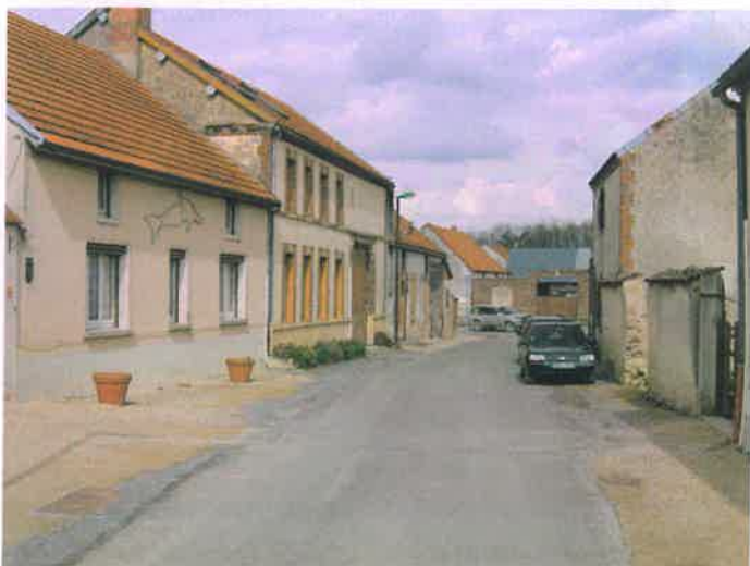
Rue de Bergères
