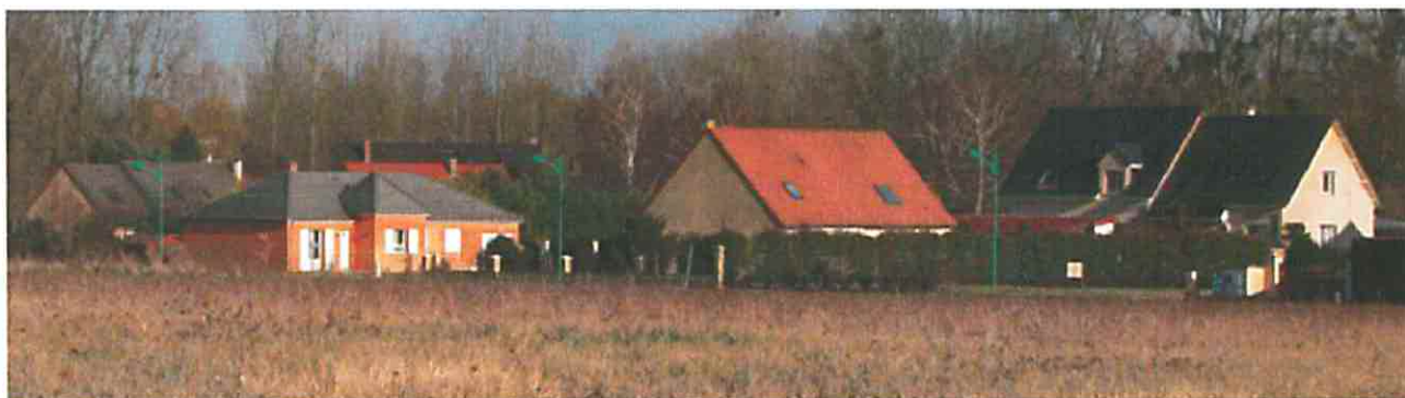
Lotissement récent avenue de l'Europe
