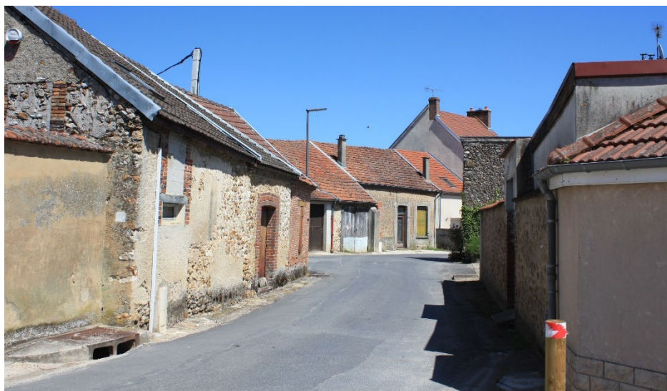
Figure 81 : vue sur le bâti élémentaire - rue du Moulin
