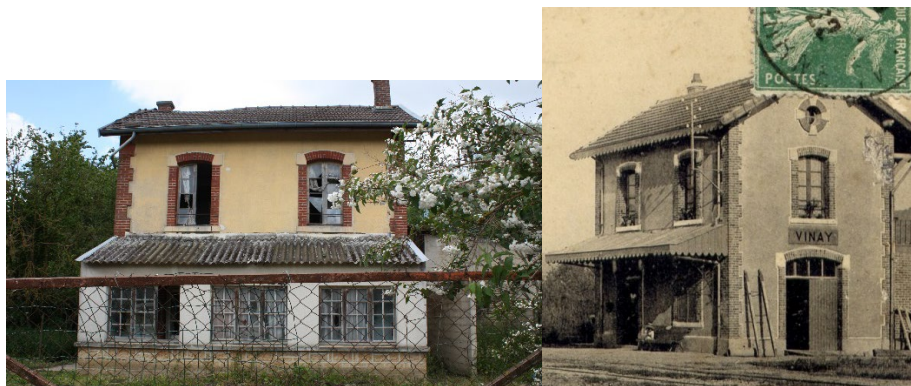
Figure 79 : ancienne gare de CBR
