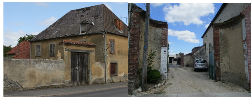
Figure 85 ; ancien porches avec présence de tuile sur le faitage - porche de style demi-lune construits pour faciliter l'entrée des carrioles
