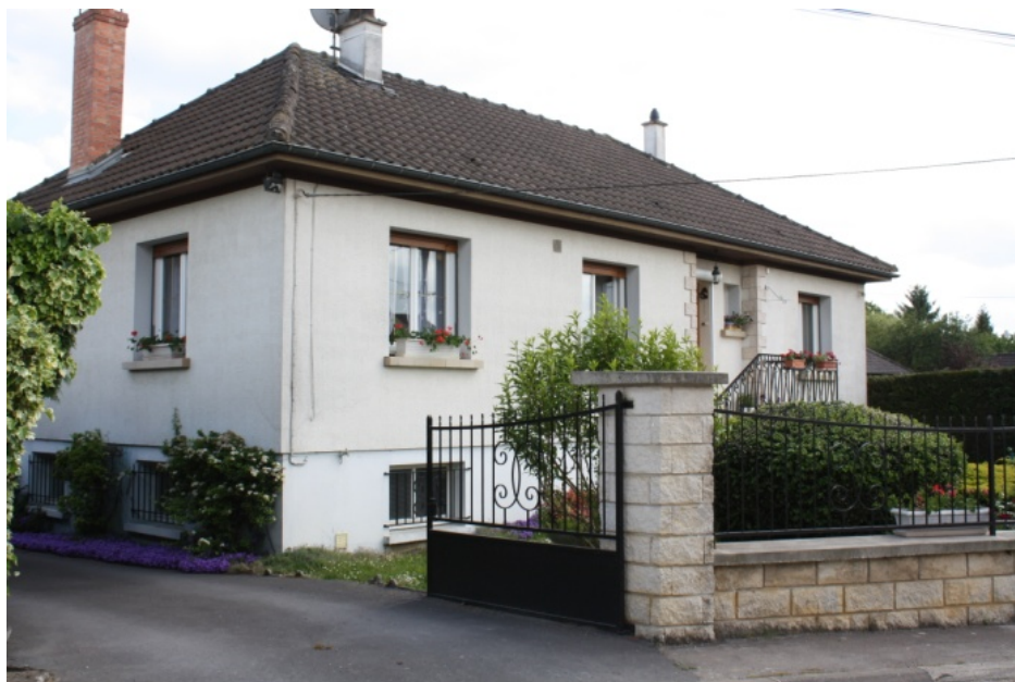
Figure 72 : maison du lotissement rue de Champagne
