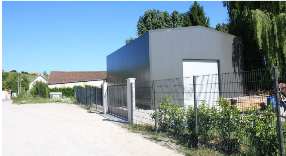
Figure 39: construction le long du Cubry dans le hameau de Tincourt
