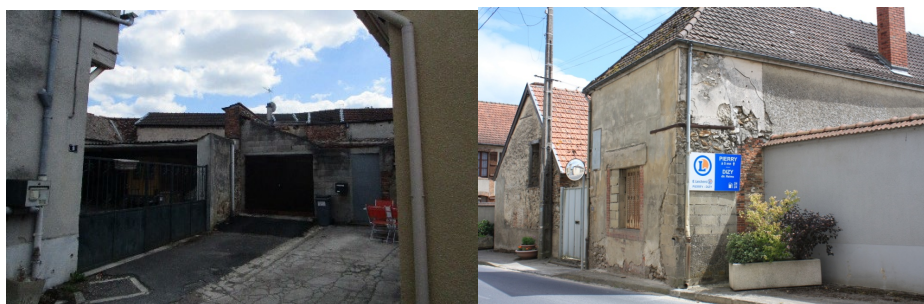
Figure 86 : mur à nu et enseigne commerciales
