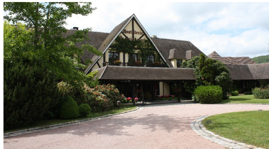
Figure 77 : bâtiment composant le site
