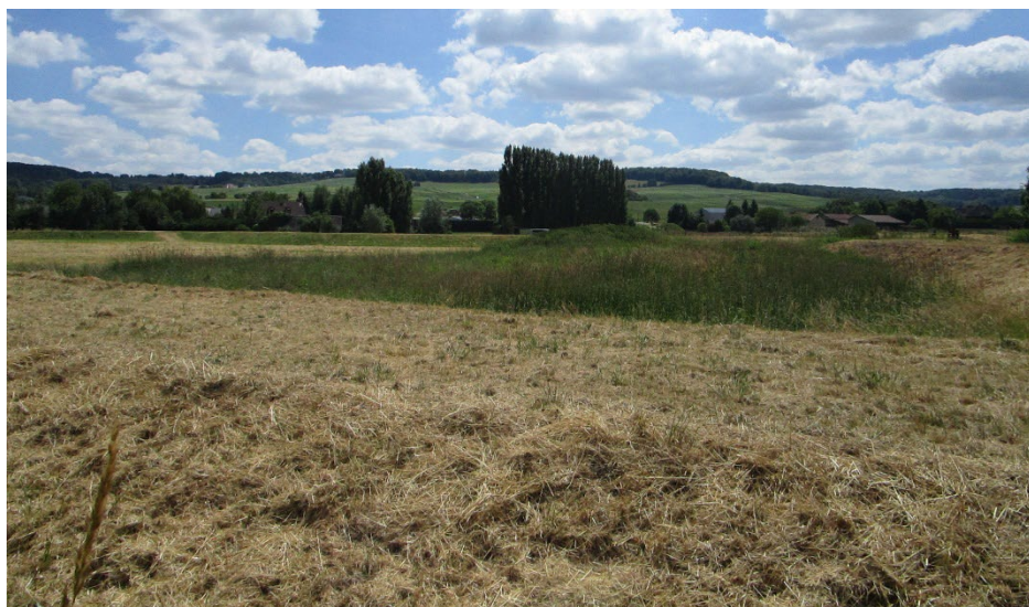
Figure 91 : le bassin d'orage à l'aval du bourg
