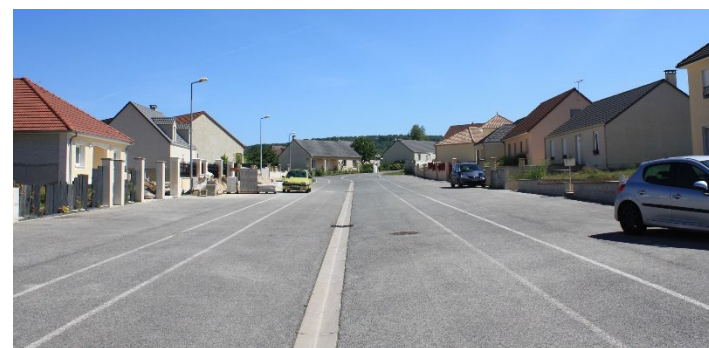
Figure 74 : voirie du nouveau lotissement
