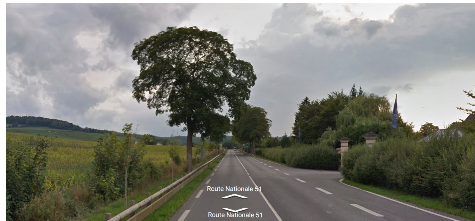
Figure 46: alignement d'arbres le long de la RD 951
