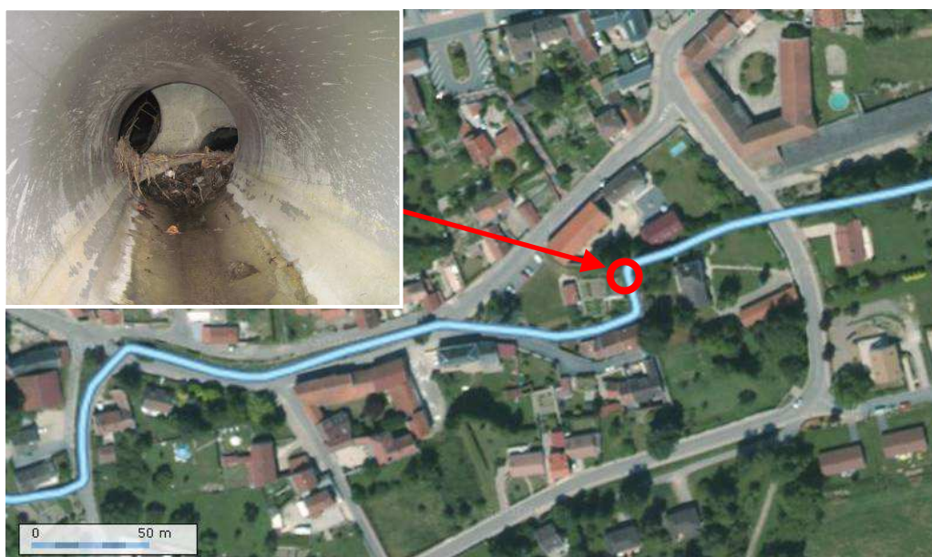
Fig. 14 : Encombrement du réseau à l'exutoire de la surverse
