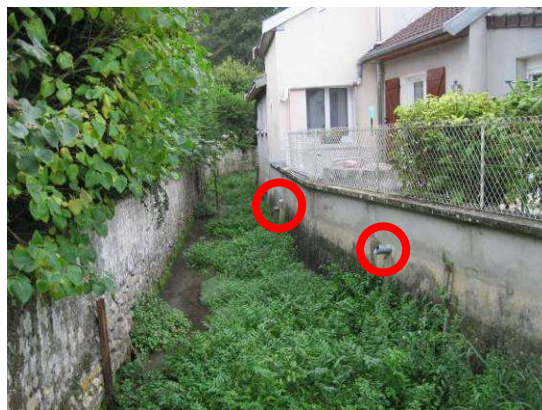
Fig. 15 : Exutoires pluviaux de particuliers
