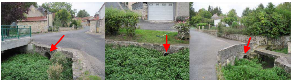
Fig. 10 : Rejets des eaux pluviales dans la Brandouille
