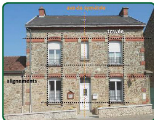
Organisation des ouvertures en façade.
