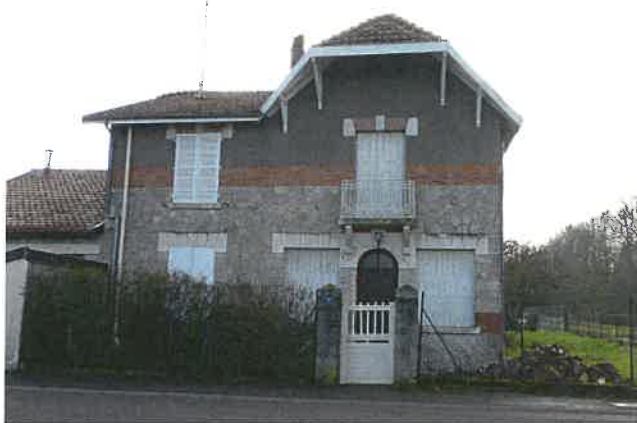
Figure 17/18 : Deux habitations élevées sur deux niveaux (sans compter les combles). A l'extérieur, les façades offrent des travées non régulières alliant la brique, la pierre et la gaize.
