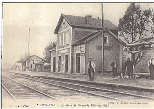
Figure 7 : La gare de Vienne-la-Ville avant sa destruction durant le Premier Conflit Mondial
