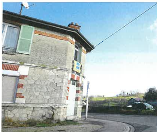
Figure 17/18 : Deux habitations élevées sur deux niveaux (sans compter les combles). A l'extérieur, les façades offrent des travées non régulières alliant la brique, la pierre et la gaize.
