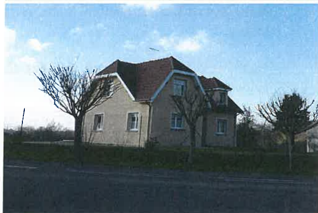
Figure 21/22/23/24 : Quatre pavillons récents : ni briques, ni gaizes, ni pierres n'ont été utilisés. Les façades en bétons plein sont crépies par la suite.
