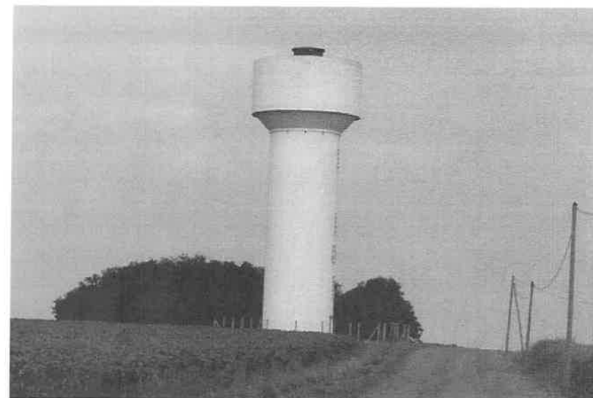
Photo n° 19 : Le Château d'eau
