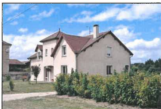
Pavillon sur une ancienne dent creuse Source TOPOS
