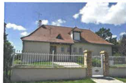
Pavillons récents Source TOPOS
