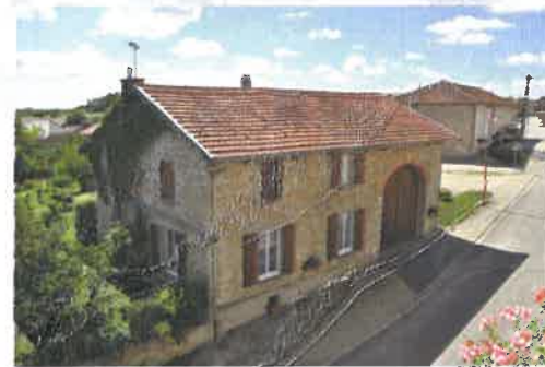
Construction ancienne rénovée Source TOPOS
