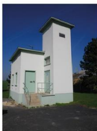
Captage AEP Puits 1 de Gueux
