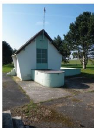
Captage AEP Puits 2 de Gueux
