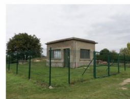
Captage de Thillois
