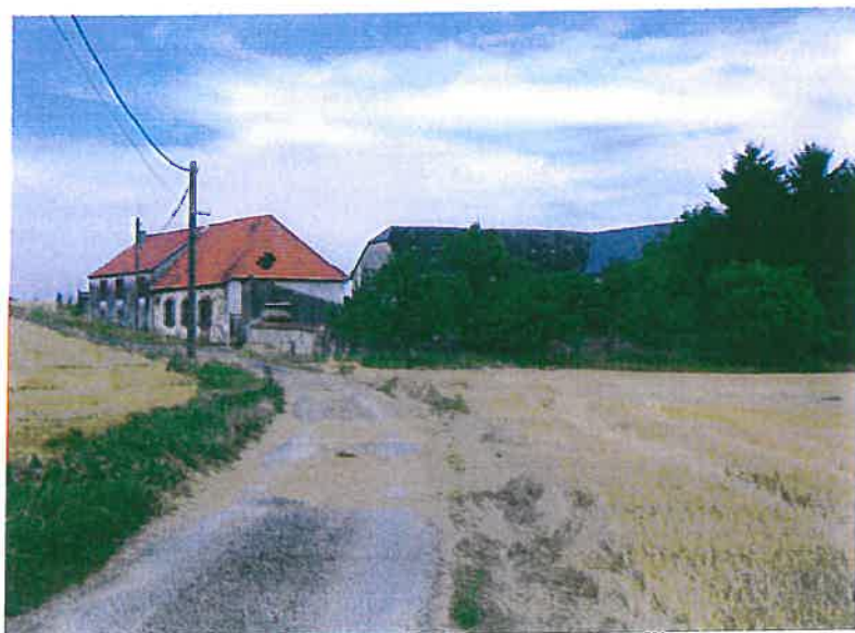
Rue du bout des haies (à l'est)
