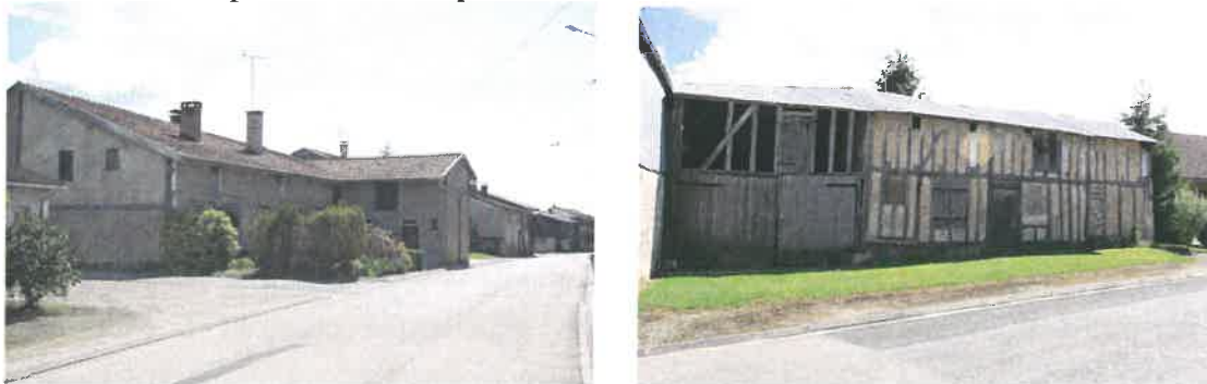
Un bâti aéré où domine une ambiance végétale
