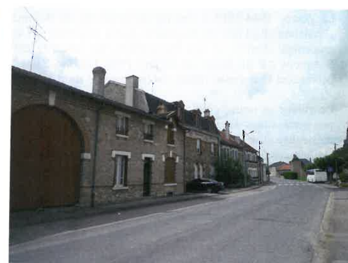
Bâti ancien rue du Général Gouraud
