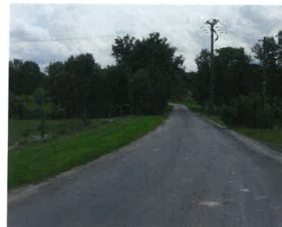
Voie communale rue du Mont Tierçon
