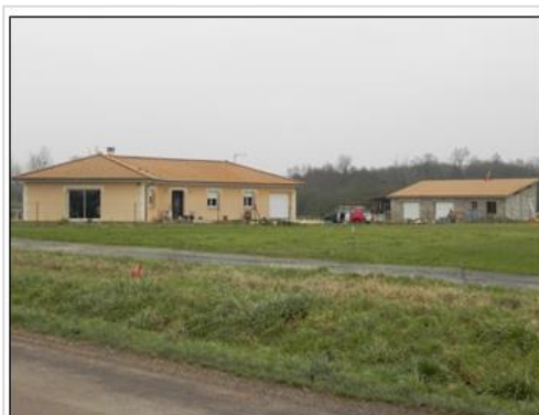
Constructions récentes rue de Vanault Source : TOPOS
