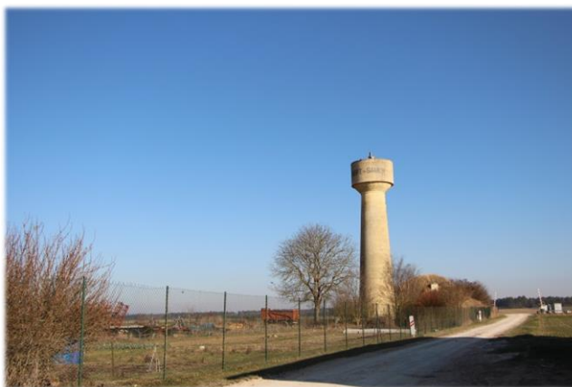
Le captage de Sept-Saulx, son château d'eau, AUDRR
