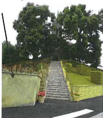
Talus de l'église
