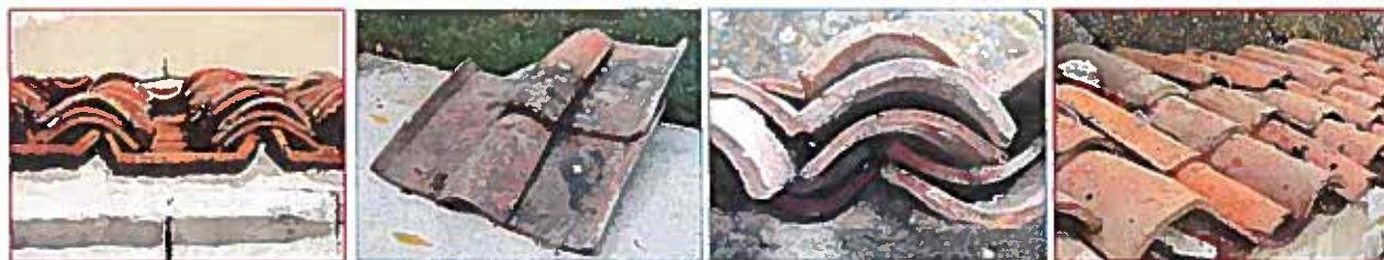
Vues ①② assemblage du type « romain » avec une imbrex (=plate) et une tegula
